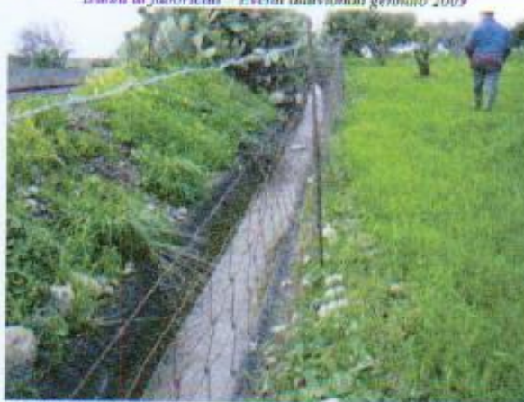
Tratto di canale che costeggia la ferrovia – Eventi all. gennaio 2009
