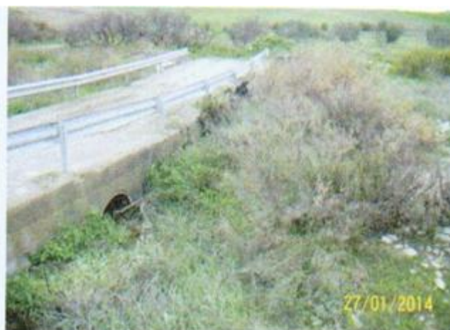
Attuale stato di fatto dell'attraversamento guado
