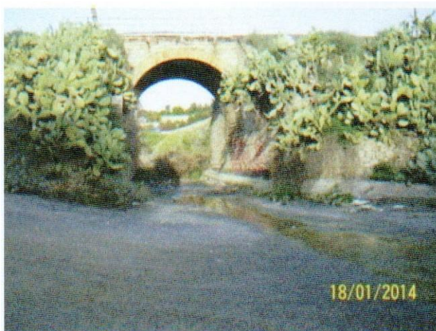
Attraversamento in prossimità ponte ferroviario
