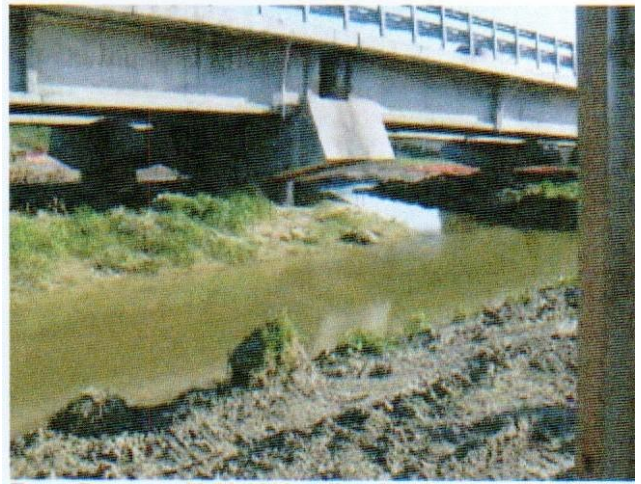
Fiume Dittaino – 22/02/2012 - Allag. Strada interp. C/da Cucco
