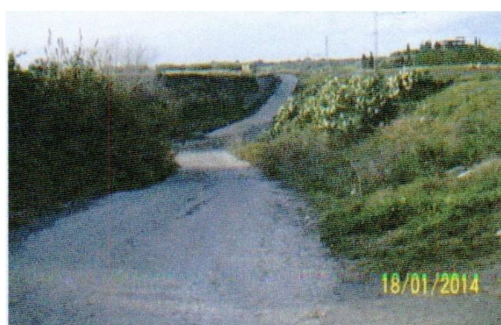
Attraversamento – guado su torrente della rosa
