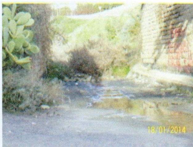
Stato di fatto sotto viadotto ferroviario
