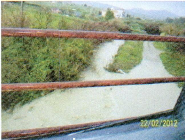
Torrente Mulinello – 22/02/2012 pross. Ponte S.R. 11.
